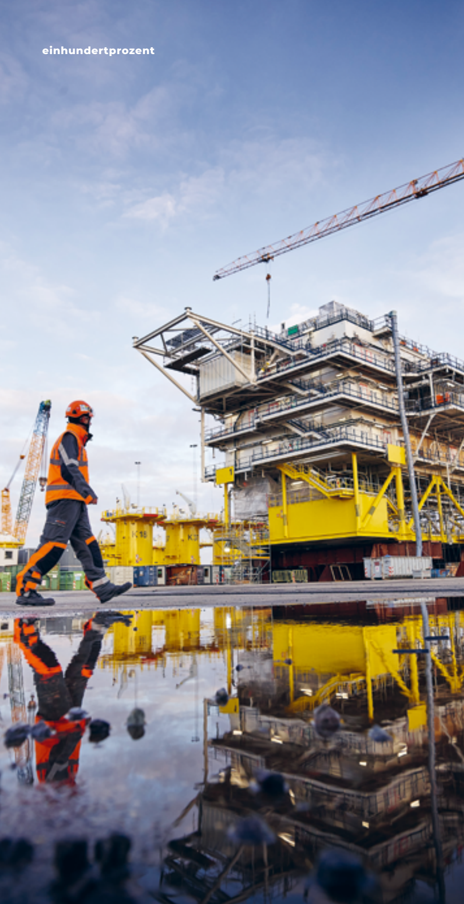
Die im Bau befindliche Offshore-Plattform für den Windpark Arcadis Ost 1 auf der Werft in Aalborg in Dänemark. Foto: Jan Pauls
