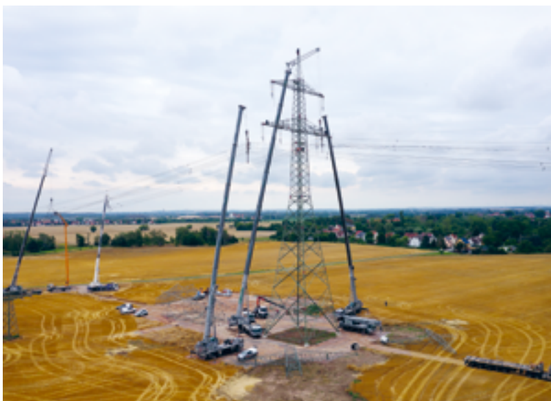
Masttausch in der Nähe von Zeithain in Sachsen. Foto: Manfred Vogel
